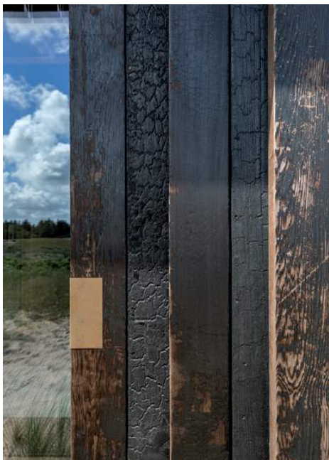
Alle materialer er nøje udvalgt, så de kan modstå det barske vejr ved Vesterhavet. Huset har sedum på taget, mens facaden er udført i en blanding af brændt og olieret cedertræ.
